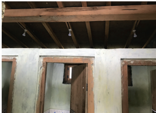
天井に設置された照明器具
