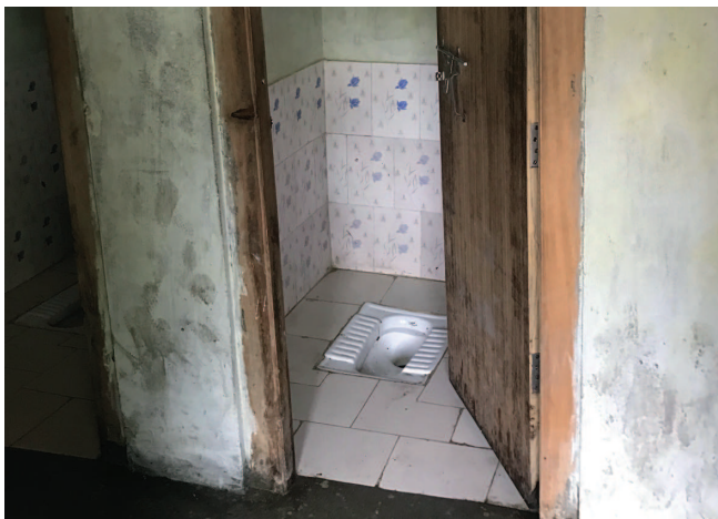
タイルを貼った便器廻り
