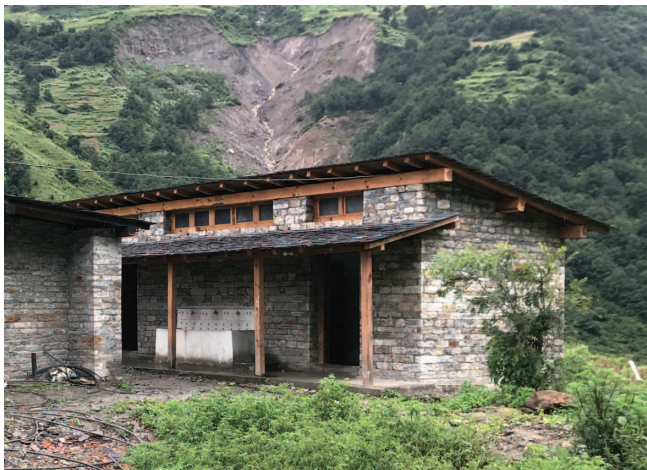
完成した便所棟
