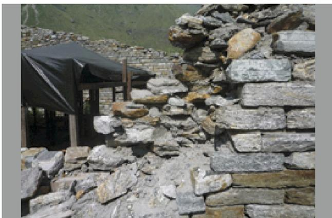
崩れた壁の詳細 石が小さくモルタルが充填されていない
