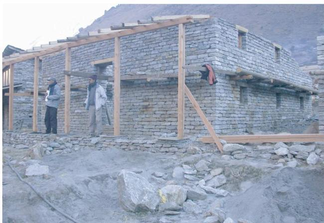
寄宿舍の工事状況 外壁がほぼ完了し、屋根を架け始めています
